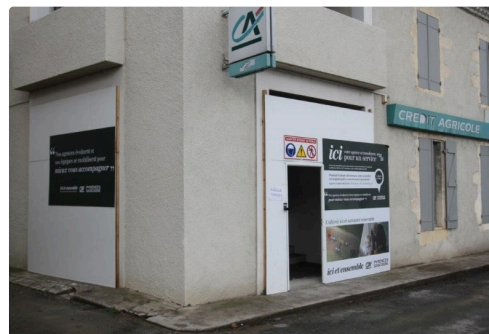
L'agence bancaire en travaux-Photos Marc Le Saux
