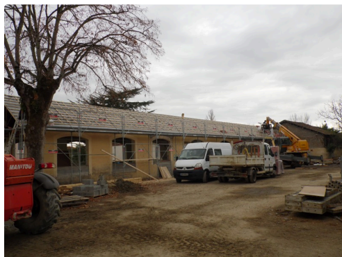
Le bâtiment N°3 en passe d'être couvert
