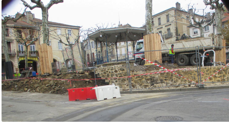
Travaux nouvelle place
