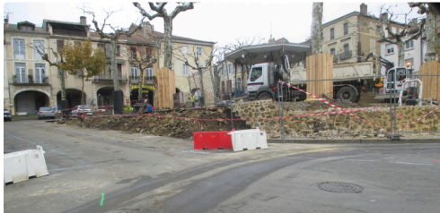
Travaux de démolition place du kiosque
