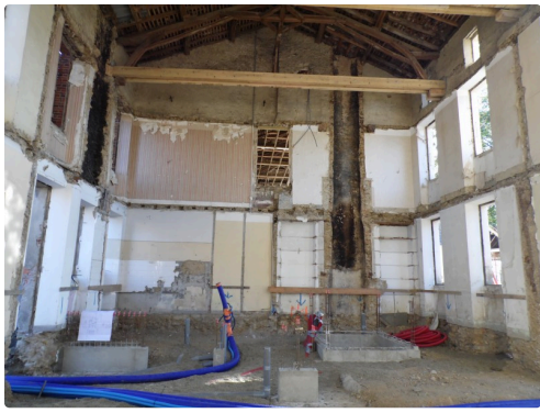
L'intérieur vide du bâtiment N°1 coté rue Sainte Quitterie
