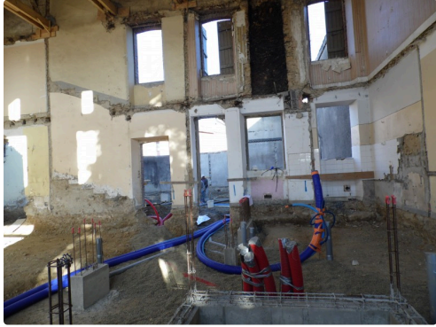
Les divers réseaux passent dans le sol décaissé du bâtiment N° 1
