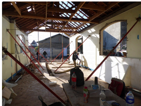
L'intérieur du bâtiment N0 3 coté rue basse
