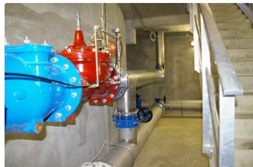
La vanne noire ouverte l'eau d'Aquitaine est passée dans le réseau d'Occitanie
