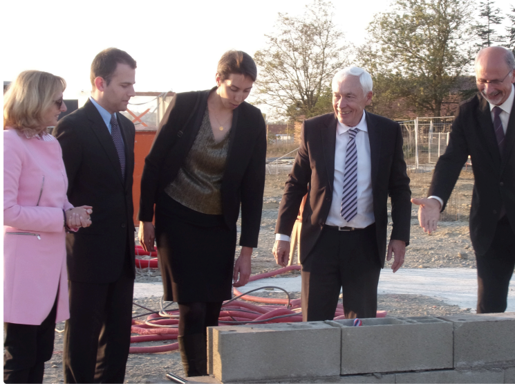
L'Isle-Jourdain / Pose de la 1ère pierre du gymnase du Collège
