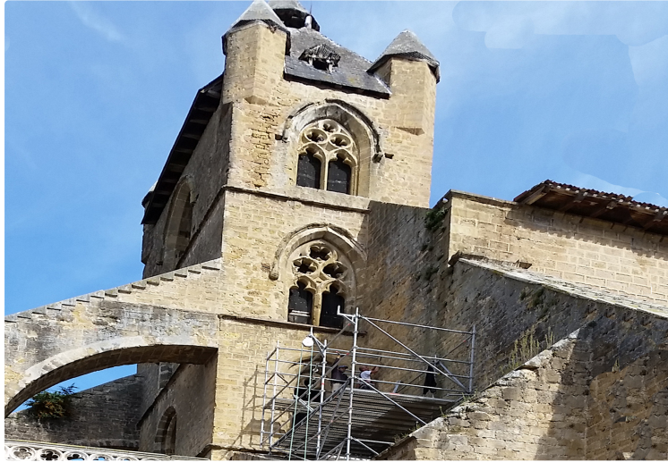
Eglise Sainte Marie, les travaux se poursuivent
