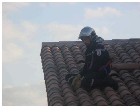
Pompier sur le toit pédagogique
