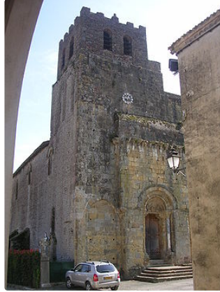
Église de Tasque : Une absidiole en pleine rénovation
