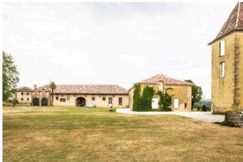
Vue d'ensemble d'une partie des bâtiments et du terrain
