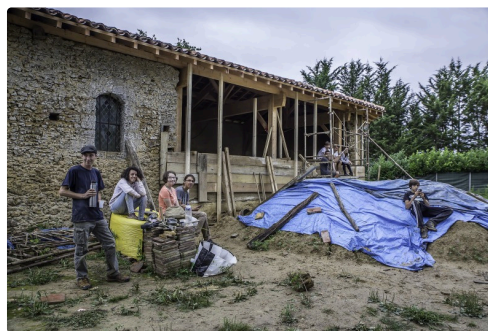
Reconstruction du mur de terre
