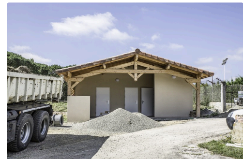
Bâtiment sanitaire pour le public (état le 27 juillet)
