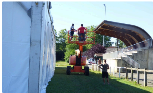
des ouvriers évoluent sur un imposant monte charge
