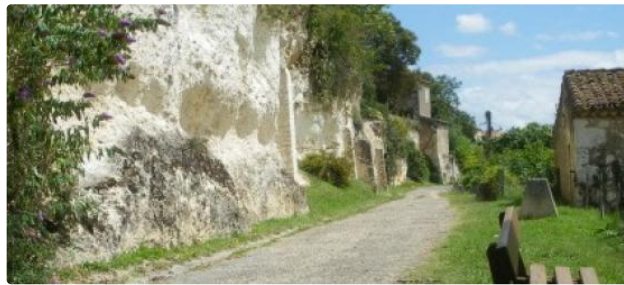
Valence sur Baïse : Les remparts mobilisent les géologues
