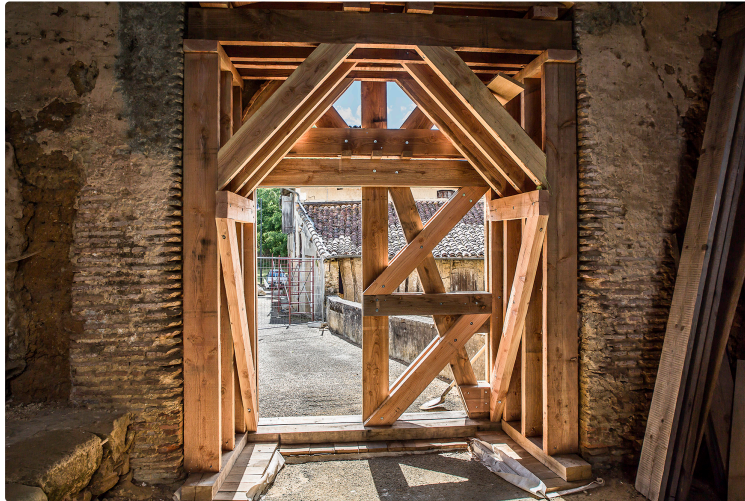
Sainte-Christie-d'Armagnac – Début des travaux au Castet
