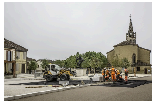
Pendant ce temps, on se hâte d’effectuer les derniers travaux d’aménagement de la place
