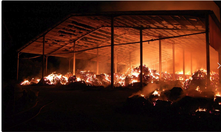
Rozès : Feu de hangars agricoles
