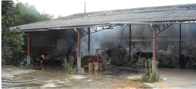
LA ROMIEU: Incendie au lieu dit "COUPET"
