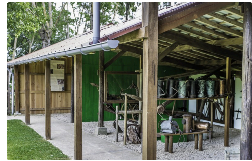
Nouvelles installations consacrées au traitement de la vigne (on aperçoit des vermores)
