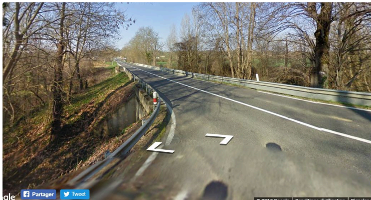
Miramont d'Astarac RN 21 : Travaux sur le pont de l'Arbiou
