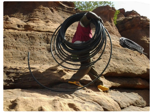
Pose de la conduite
