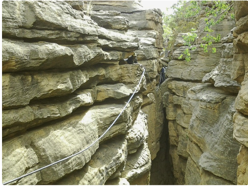
Pose de la conduite
