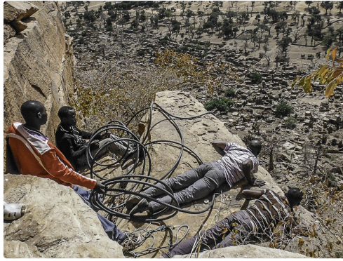
Pose de la conduite
