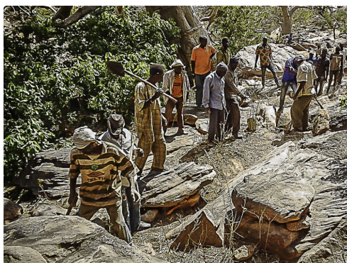
Traçage des conduites
