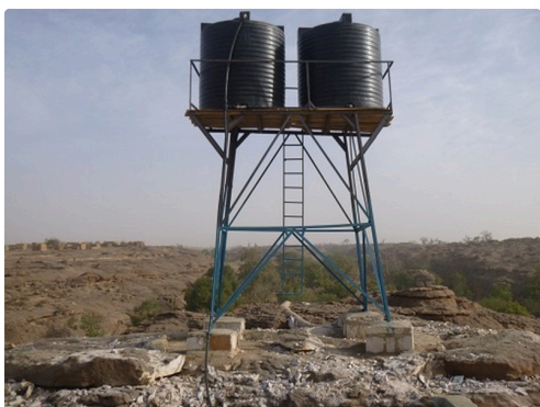
Mise en place d'une citerne
