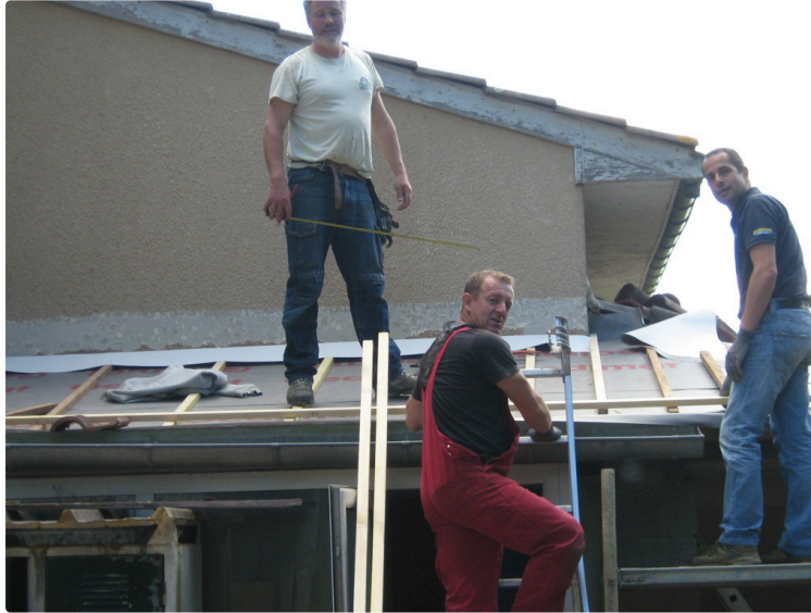
Cantine scolaire de Beaumarchès
