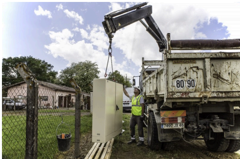
4 La bigue du camion soulève l'armoire
