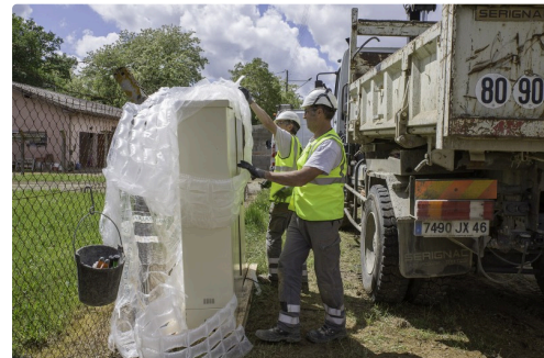
3 L'armoire est déballée
