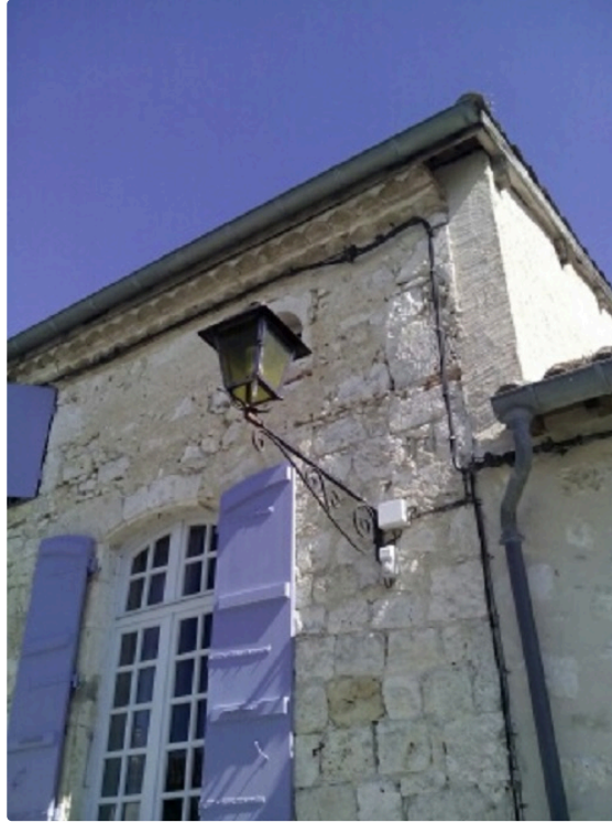
Saint Clar - Rénovation de l'éclairage public
