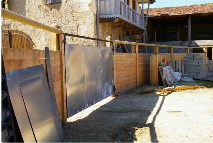
Les travaux avancement au "Corral" du Lartet
