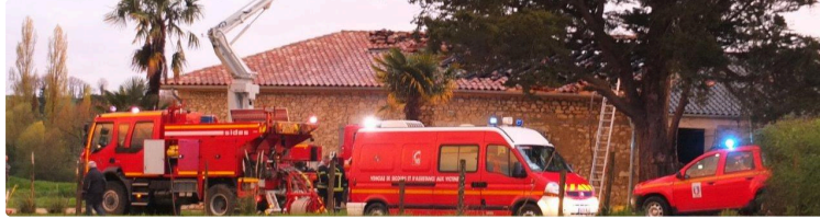
Cassaigne : Une maison détruite par le feu
