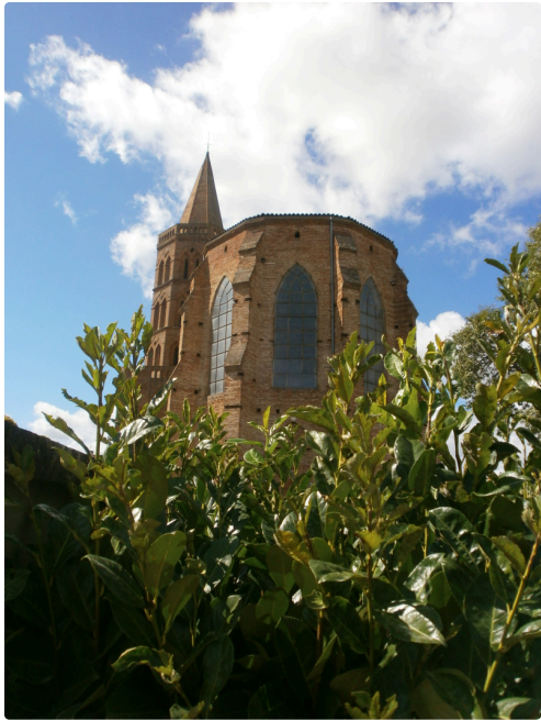
La gleisa e le cloquèr de Daux - L'église et le clocher de Daux
