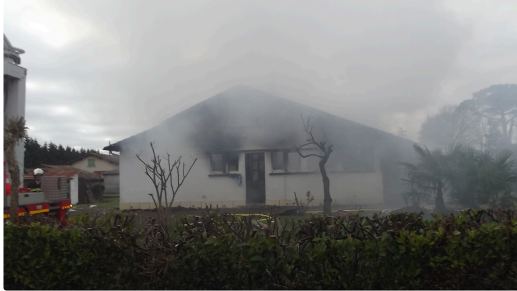
Plaisance : Explosion suite à une fuite de gaz dans une maison rue Adour ce matin à 7 h 30
