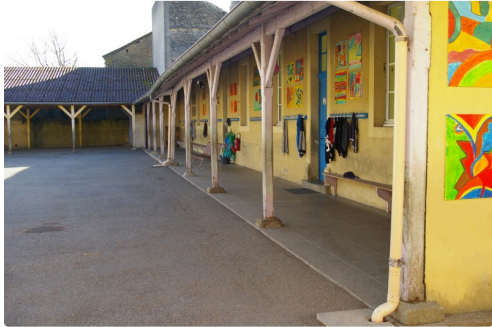
Le bâtiment actuel répertorié N°3 situé coté rue Sainte-Quitterie , la coursive sera enlevée
