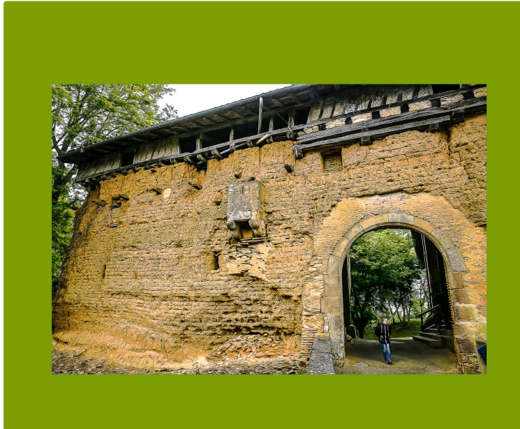
Sainte-Christie-d'Armagnac – Gros travaux au Castet
