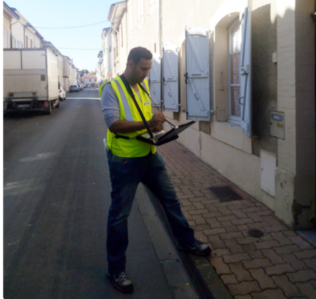
La fibre optique dans la sous préfecture
