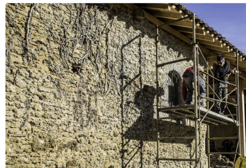
Les lianes et autres plantes recouvrent les murs extérieurs
