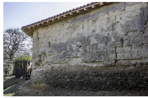
Ce mur n'étant plus abrité par un toit très débordant, un renfort de pierres ultérieur protège de la pluie le bas du mur
