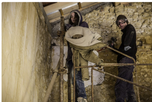
Les murs intérieurs aussi sont décapés
