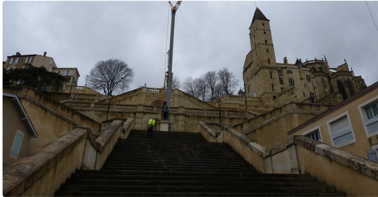
AUCH : ESCALIER MONUMENTAL
