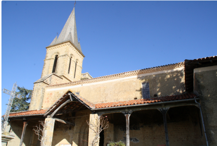
Sainte Dode : Rénovation de l'église
