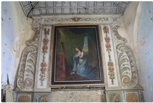
Le sanctuaire à rénover
