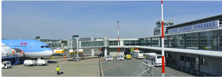
Aéroport de Tarbes-Lourdes-Pyrénées en plein essor
