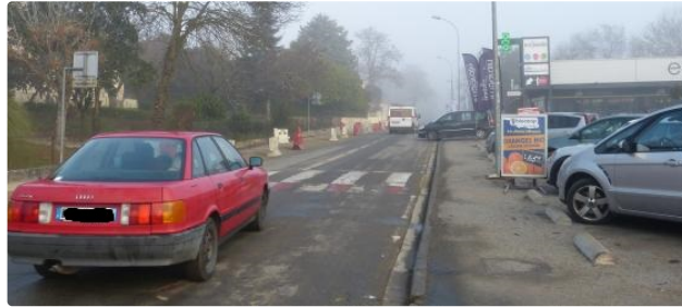
Auch, rue du 8 mai : Seconde phase des travaux à partir du 16 janvier
