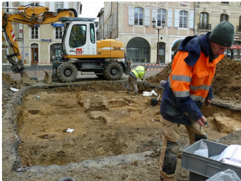
Vue globale du chantier.
