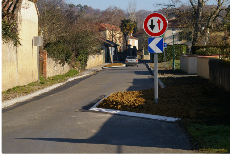
A Tasque la traversée du village a été sécurisée
