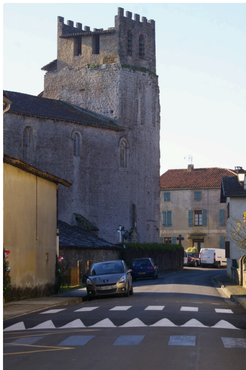
Face à la mairie et à l'école le passage surélevé oblige à lever le pied
