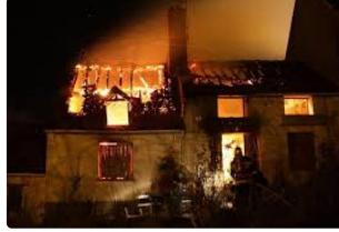
Une maison détruite à Samatan suite à un incendie : une victime a pu être secourue
