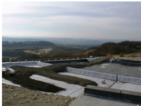
Vue d'ensemble de quelques casiers.
