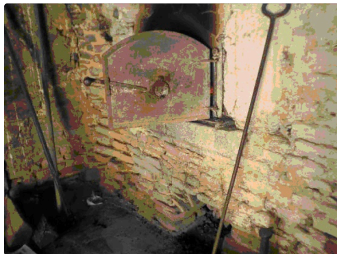
Détail de la porte du four
