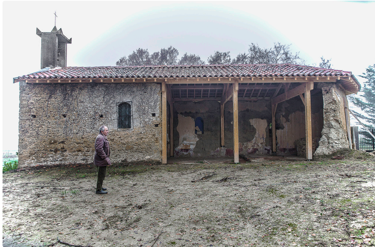
Magnan – Une chapelle en terre crue va renaître
