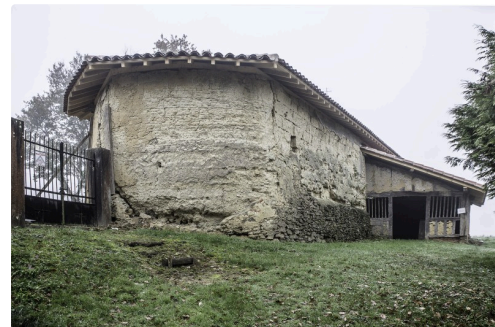
Vue de l'extérieur côté est
