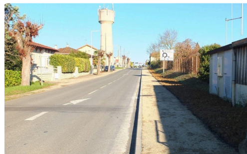
Le chemin piétonnier est quasiment terminé.
