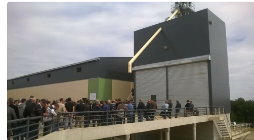
Les nouveaux silos Crédit Photo RMP
