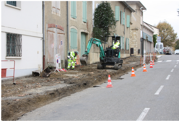
Travaux de voirie
