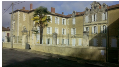
maison de santé travaux 3.jpg
