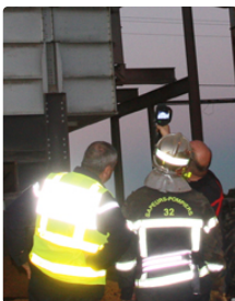
L'utilisation de caméra thermique permettait de suivre l'évolution du point de chauffe dans la tour
