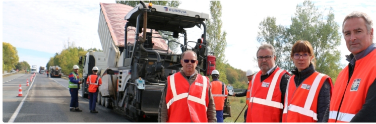
Chantier sur la RD924 à Auch du 11 au 20 octobre : réfection de la couche de roulement
