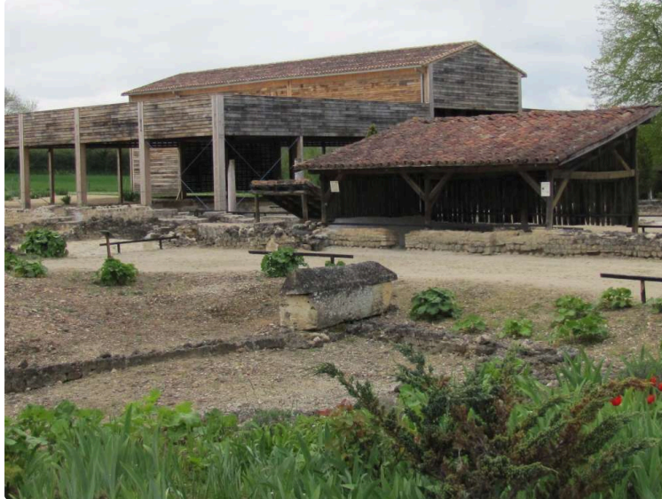
Montréal du Gers : Fermeture de la Villa de Séviac pour cause de travaux
