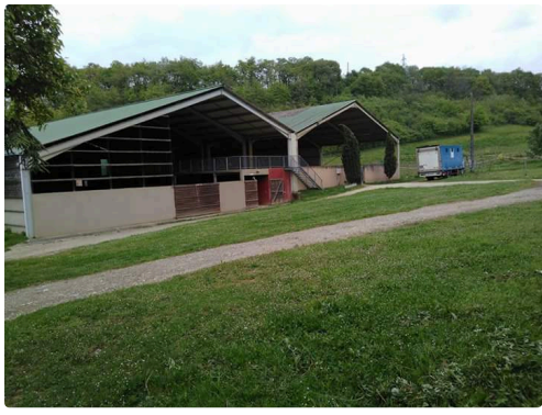
structures du centre équestre
